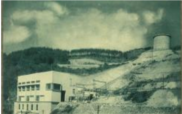
完成時の虻田発電所と調圧水槽
