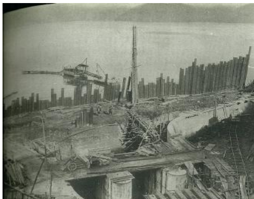
工事中の虻田発電所取水口
