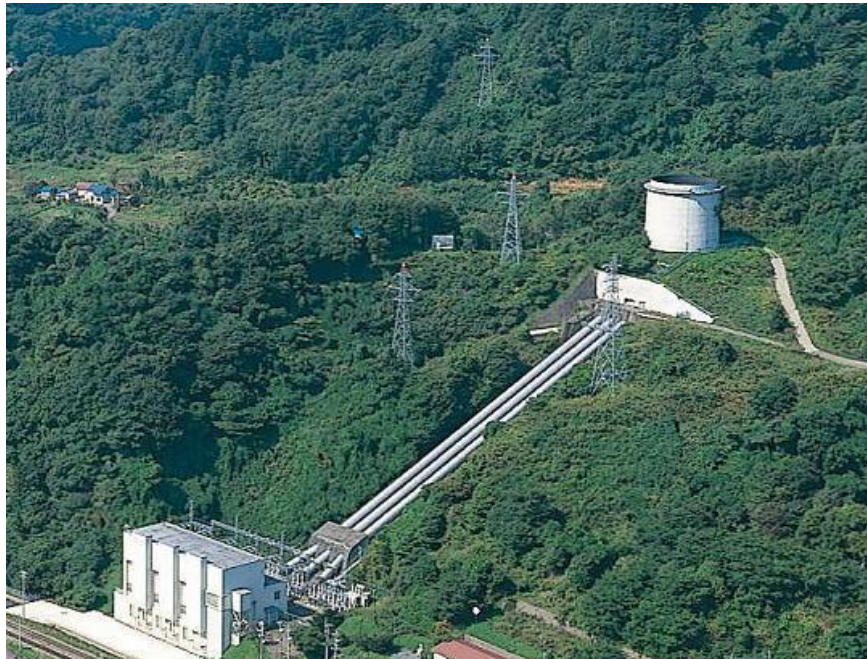
虻田発電所全景
