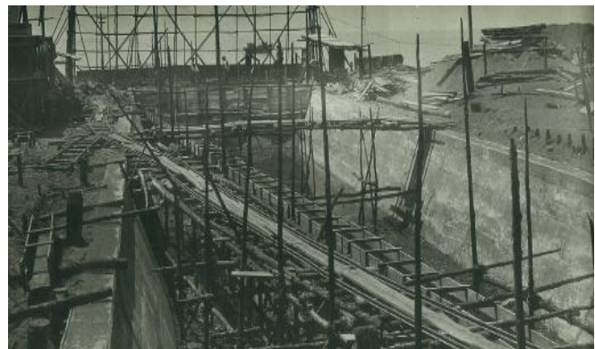
工事中の虻田発電所放水路
