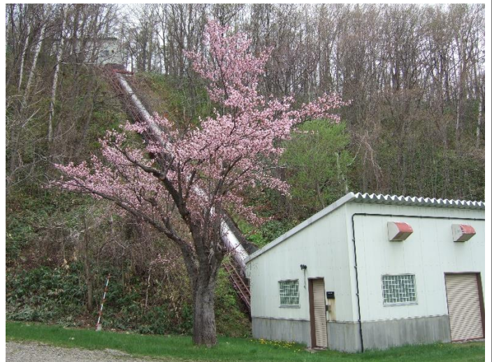
写真1 秋の川発電所外観
