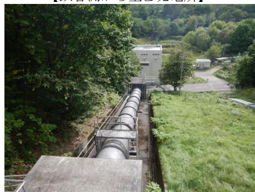
【鉄管側から望む発電所】
