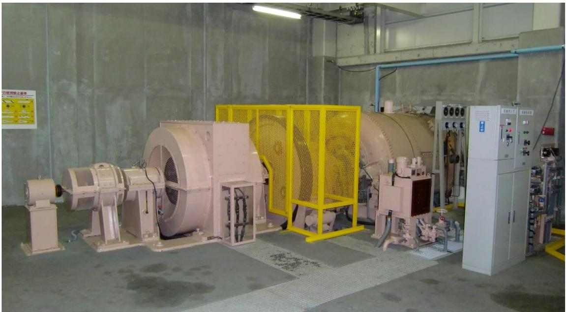
【濁川発電所 既設水車発電機（水車：横軸双輪フランシス水車）】
